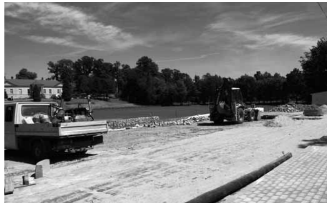
Budowa parkingu przy ul. Podzamcze
